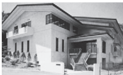
改修が予定されている 湖北衛生センター
